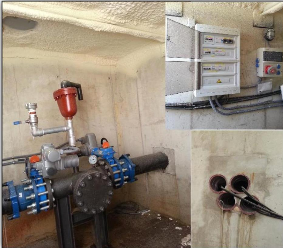
Fotografía: detalle del proyectado espuma de poliuretano, pasatubos e instalación eléctrica
