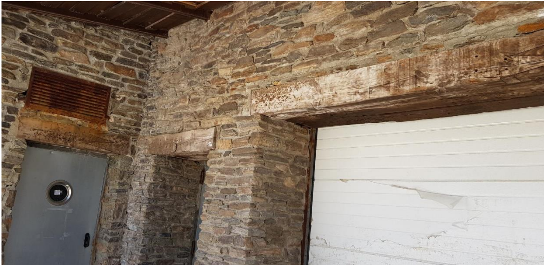
Imagen 11. Reparación de dinteles.
