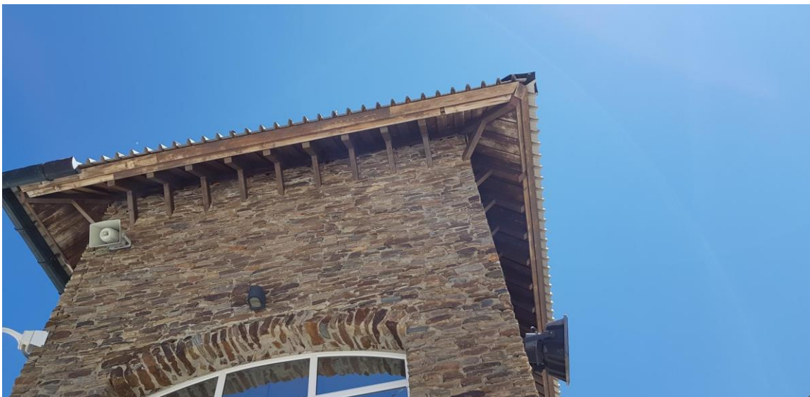
Imagen 10. Reparación de Aleros.
