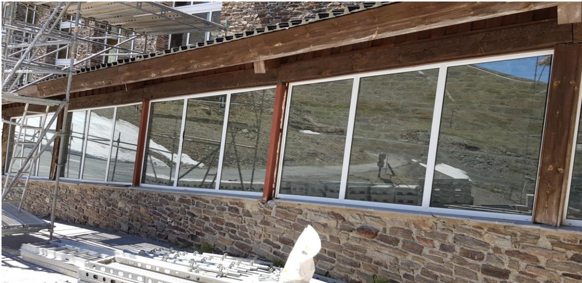
Imagen 9. Pilastras de madera para reponer, reparación de aleros y dinteles.
