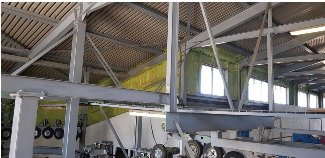
Imagen 2. Otra vista de la zona a panelar en la estación superior del Telecabina Al-Andalus.
