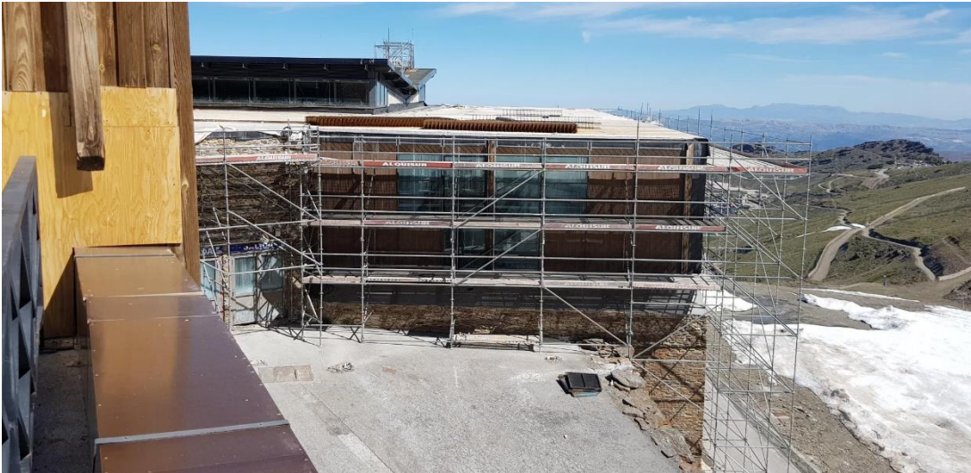
Imagen 7. Lateral de la fachada Chill-Out, en su perímetro se construirá el zuncho y se volverá a panelar.
