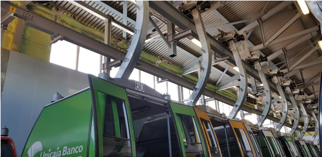
Imagen 3. Zona del garaje de las cabinas, donde hay que panelar la parte superior, como se aprecia en esta imagen.
