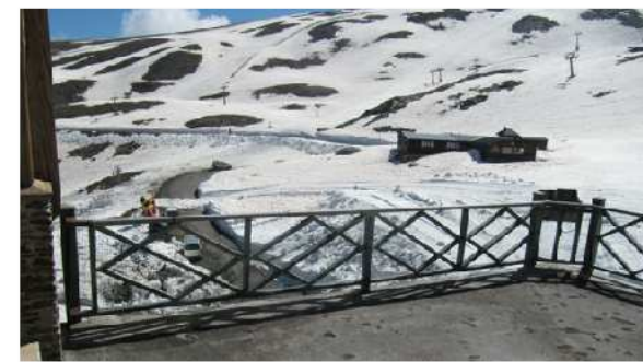
30.60m. de Barandilla a Acondicionar
