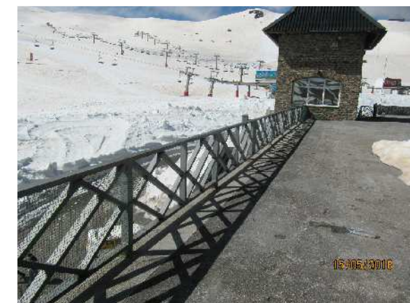
65.00m. de Barandilla a Acondicionar
