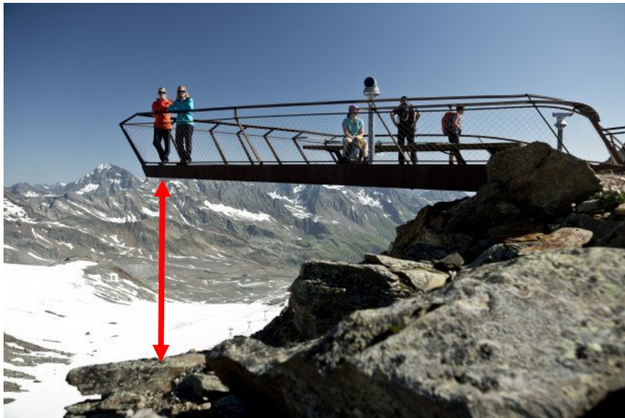
Foto 8: Apoyos metálicos en las bases de hormigón para reforzar pasarela
