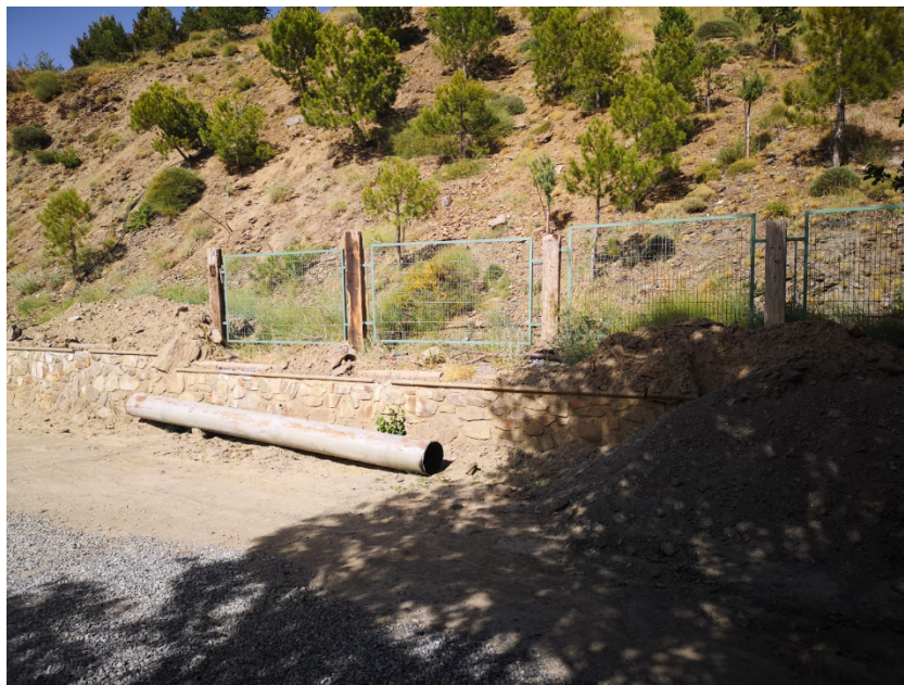
Foto 2: Vallado perimetral zona Mirlo
